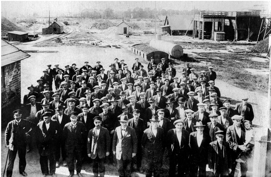
Gruvarbetare vid schakt 1 och 2 efter lottning. Man lottade om arbetställena nere i gruvan.
