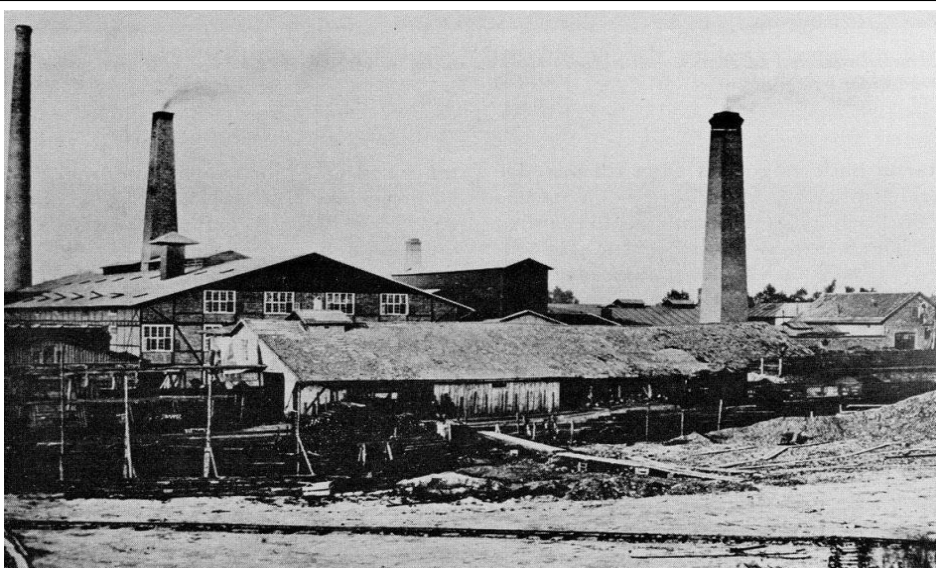
Schakt II i Bjuv med "tegelverket" låg på Bjuvsverkens nuvarande område. Detta schakt var 1872—1905 ventilationsschakt och blev sedan uppföringsschakt till 1930
