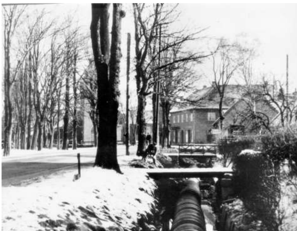
Igenläggning av kanalen vid gamla kyrkan. 1936
