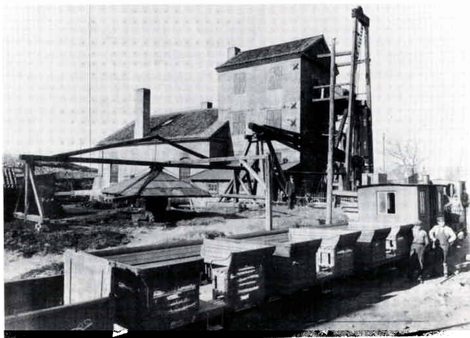
Fig. 6. Exteriör av Samuel Owens balansångmaskin för länshållning i Ryds schackt, byggd 1829–1831. Denna maskin finns idag bevarad i Sveriges Tekniska Museum i Stockholm där den intar en central plats i maskinhallen. (Foto Sveriges Tekniska Museum, 1926 eller tidigare)
