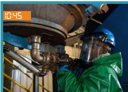
Chris bär personlig skyddsutrustning när han ansluter en slang för att tömma vätska från dubbelkonblandaren efter att ha blandat en sats Cleanit® LC. Vätskan filtreras och pH-värdet neutraliseras till en acceptabel nivå innan vätskan släpps ut i det kommunala avloppssystemet.
