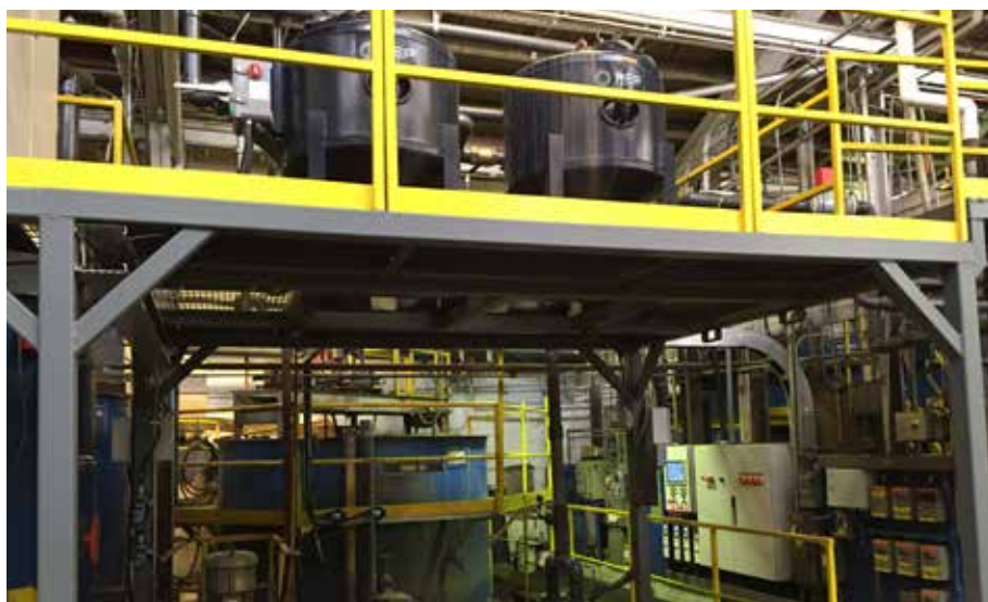
Johnstowns avloppsreningsverk renar processvattnet innan det lämnar anläggningen. Överst i bilden syns de båda nya sandfiltren som ingick i uppgraderingen.
