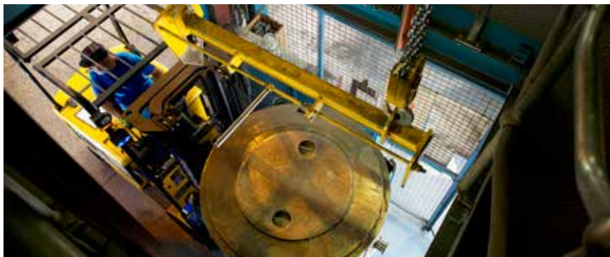
14:30 Basken lyfts av en stor kran och ska ställas ovanpå Metrova-blandaren.
