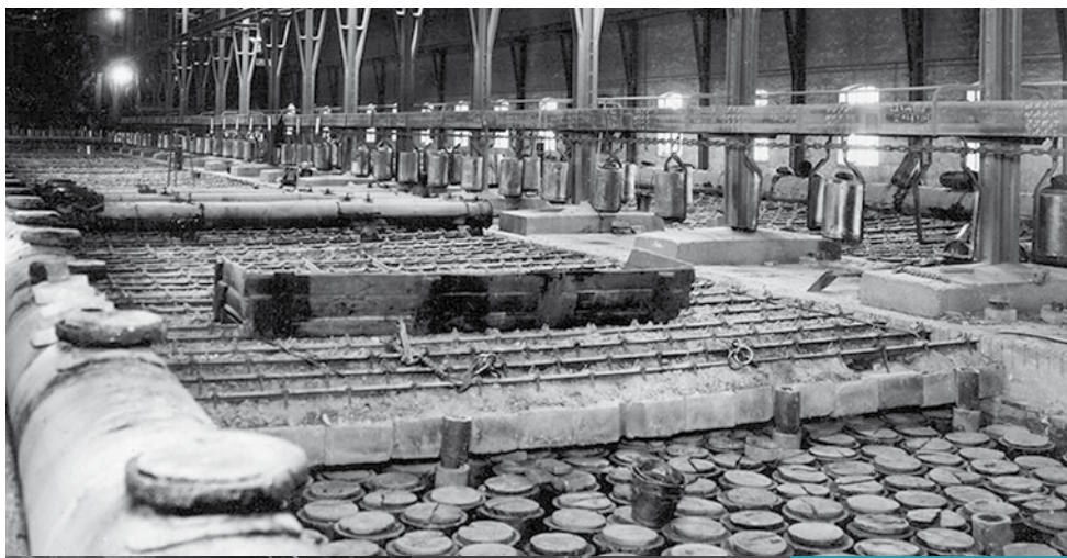
Ovan: Till en början användes gropugnar vid tillverkning av järnsvamp.
