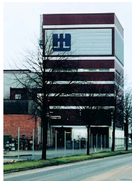
Skrot är basråvaran för Höganäs Halmstadverken. Anläggningen levererar baspulver till Pulververket samt låglegerade Astaloypulver till Distaloy- och Astaloyverket i Höganäs.
