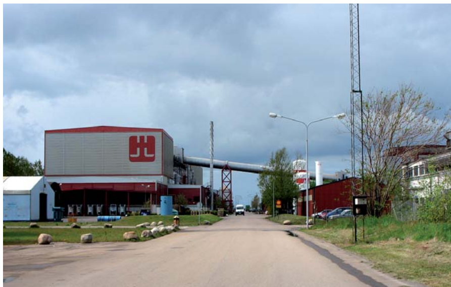
Baspulver från Pulververket transporteras till Distaloyverket, till vänster på bilden, via ett stort transportrör.
