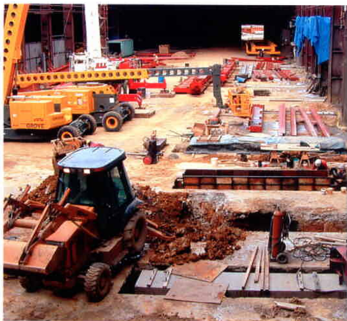
Det är redan full byggaktivitet i den långa fabriksbyggnaden i Stony Creek. Taket skall t ex på två ställen höjas till 30 meter.
