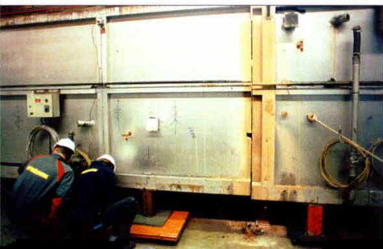
Bandugn nr 24 skars med hjälp av diamanttråd i tre delar. Därefter flyttades varje ugnsdela med luftkuddar.
