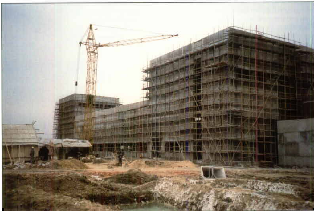
Atomiseringsverket i Kina är till storleken något mindre än Distaloyverket i Höganäs. Arbetsställningarna som löper runt fabriken är av bambu!
