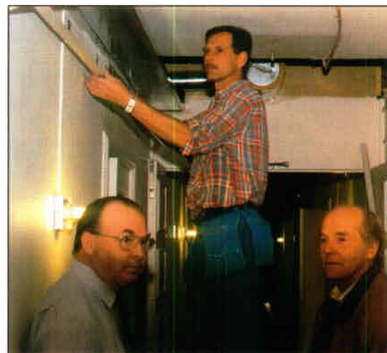
Gösta Boberg och Hans Lidholm studerar monteringen av det ljuddämpande undertaket.
