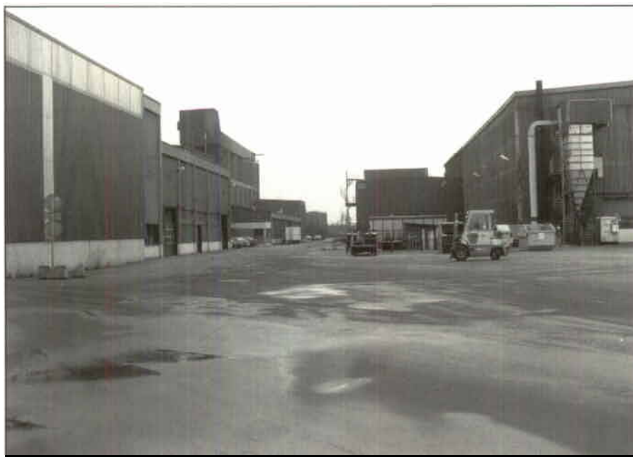
Svampverket och Pulververket var två anläggningar som stod i fokus vid den stora fabriksinvigningen i Höganäs den 21 oktober 1963.
