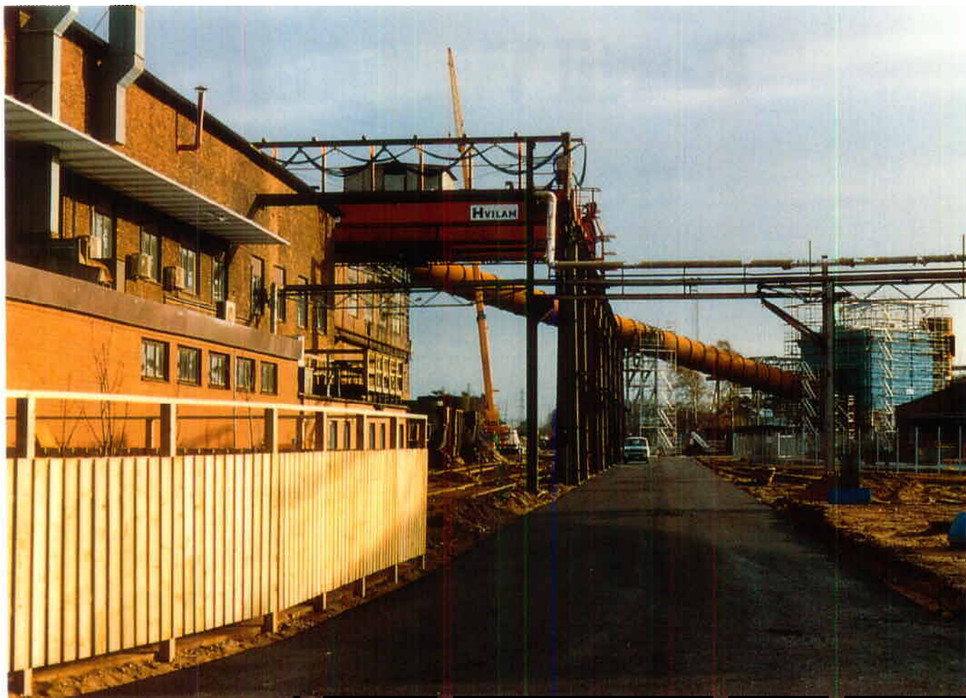
Gamla Halmstad Jernverk har snyggats upp grundligt. Fasaderna har tvättats, den drygt 200 m långa byggnaden har fått nya fönster och körvägar har asfalterats. Till höger på bilden kan man också skönja den nya filteranläggningen.
