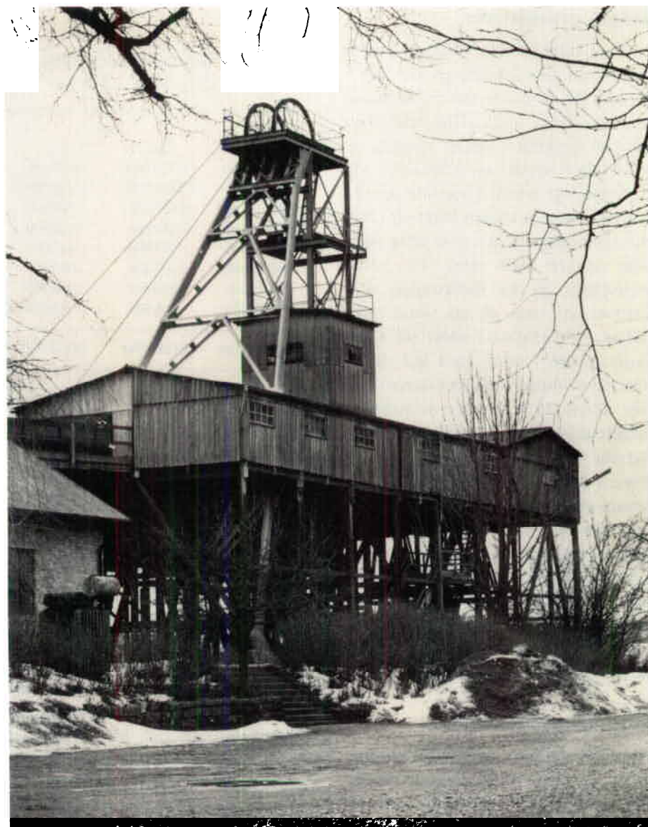
En vy som kommer att försvinna. Gamsen, som byggnaden kallas, skall rivas. Det var här som gruvarbetarna tog hissen ned i underjorden och upp igen efter en dags hårt arbete.
