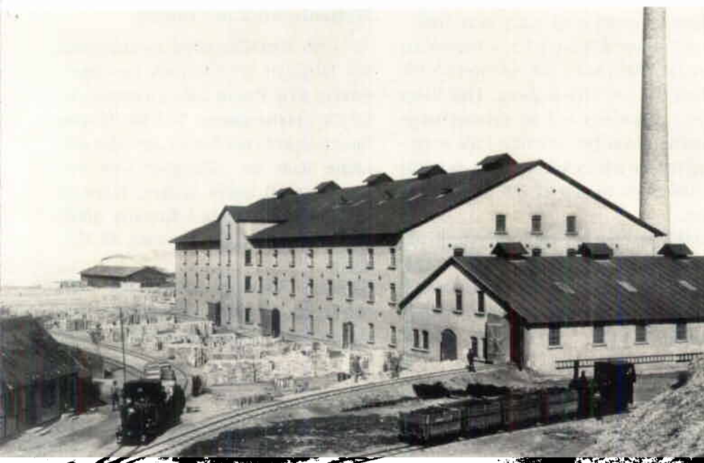
Fabrik V. Kring sekelskiftet. Uppförd 1893–1894.
