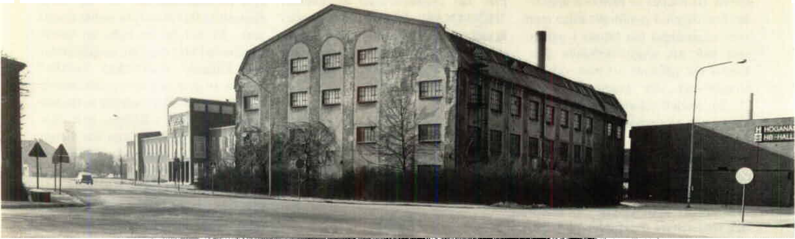
Fabrik III mot Bruksgatan. Centrallaboratoriet tv HB-hallen th.
