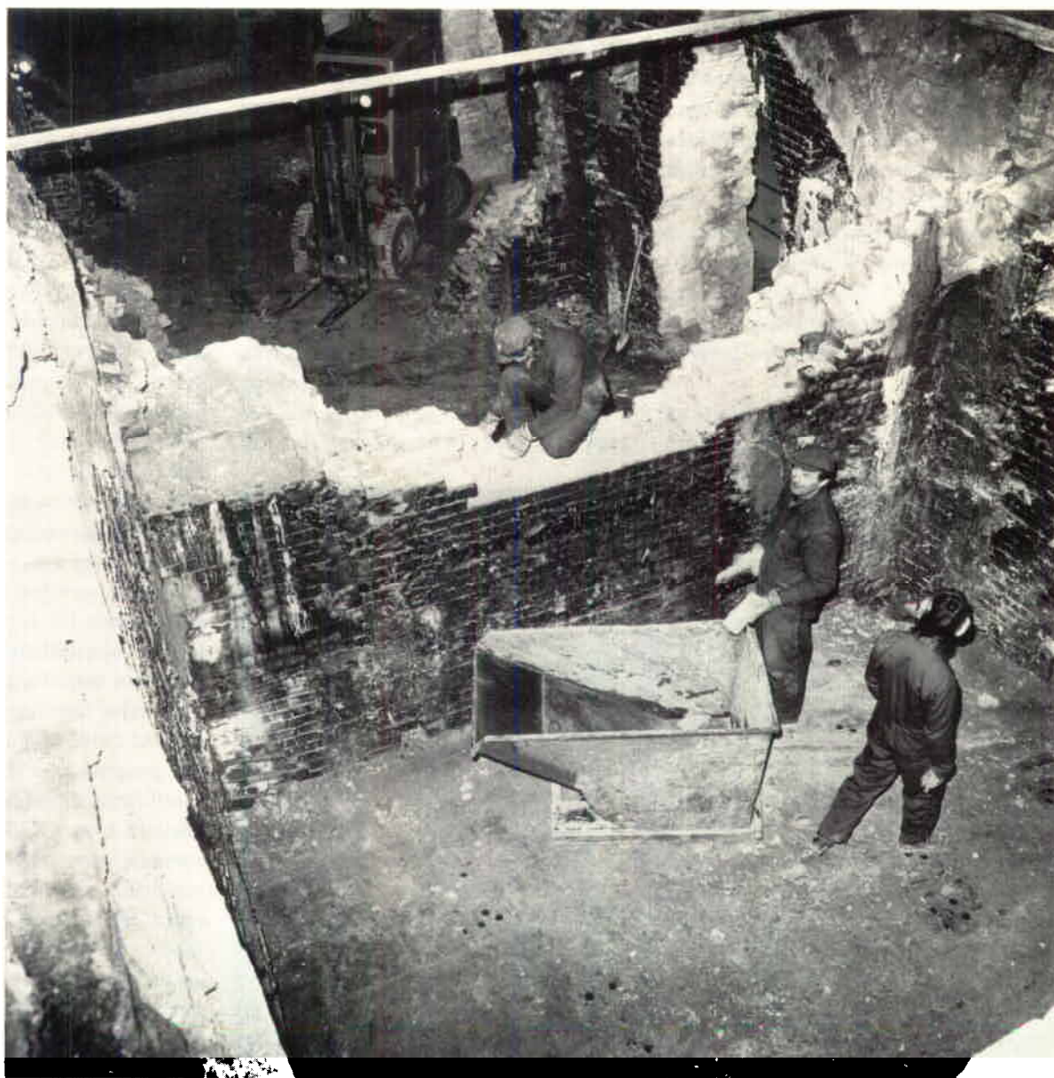
Återvinning av eldfast tegel i fabrik VI.
