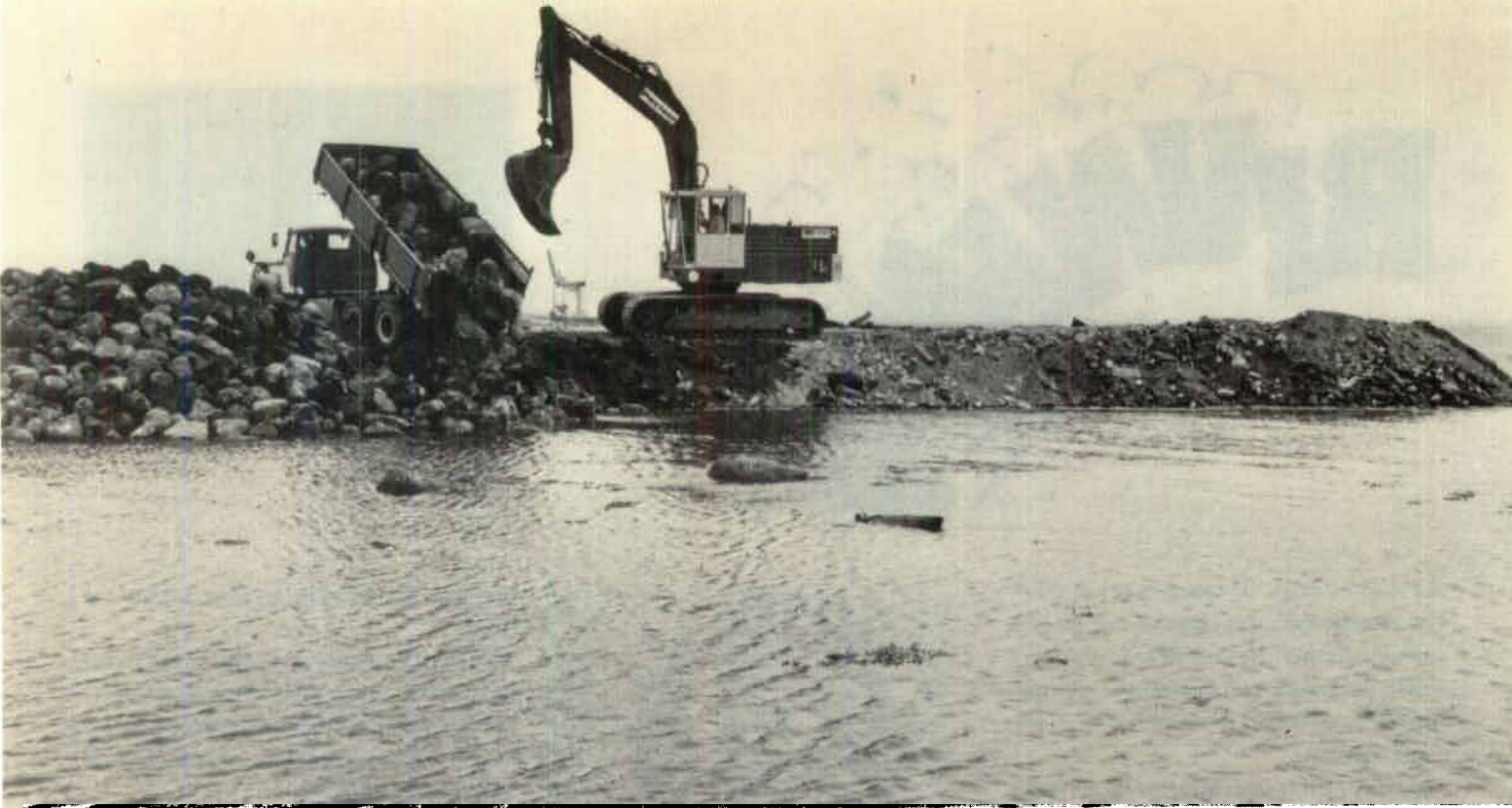
Invallningen har påbörjats.
