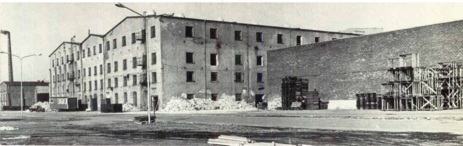
Rörfabriken. – Fabrik X och VI.
