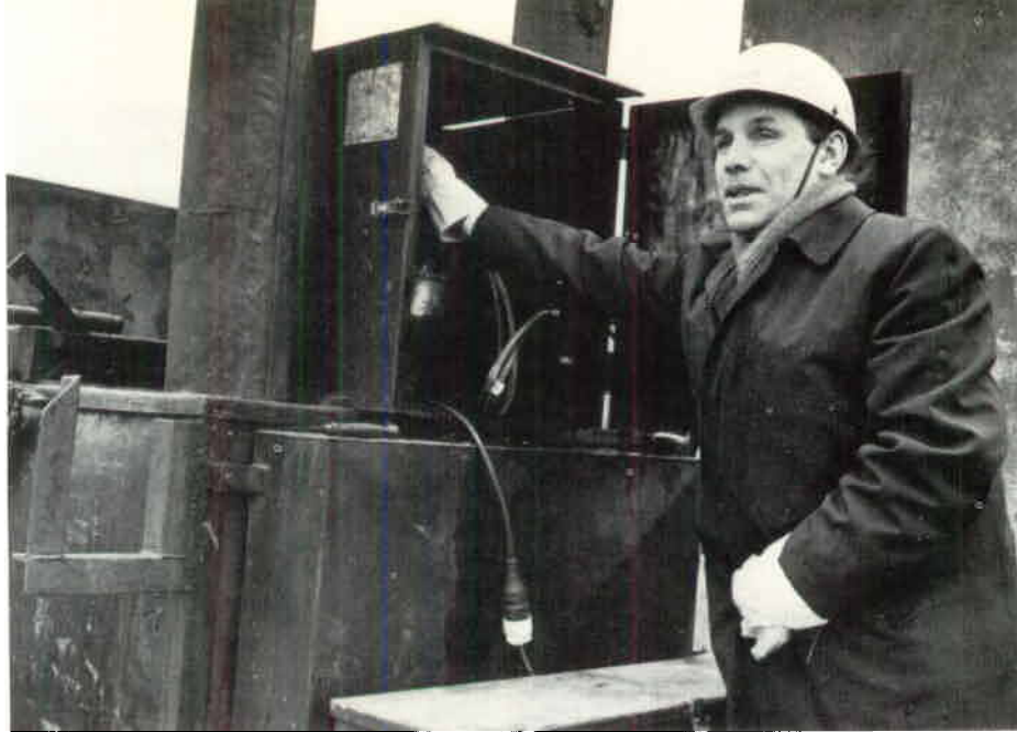
Lennart Gerle vid en pumpkokare som används till asfaltmältning.
