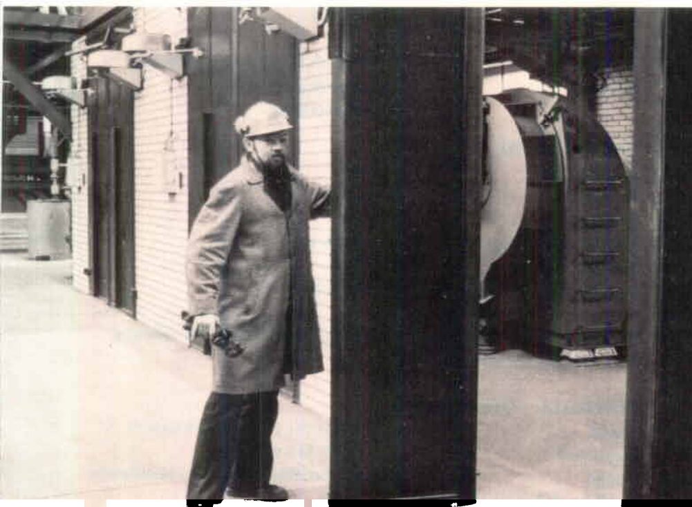
Innanför de här portarna har kvarnarna byggts in i ljuddämpande syfte. Hans Christer Kierkegaard visar.
