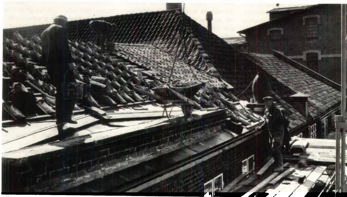
Taket på den ena byggnaden har lagts om med enkupiga gula tegelpannor, mellan 50–80 år gamla. En enhetlig och livfull takbild har erhållits.
