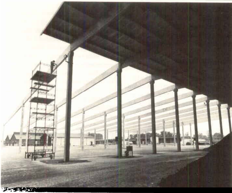
En uppfattning om takets storlek får vi här.
