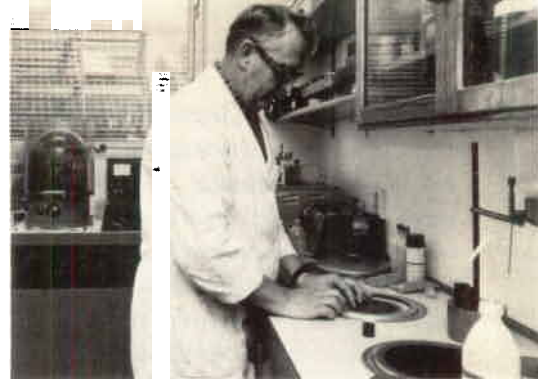
Hans Svensson polerar prover för metallografisk undersökning.
