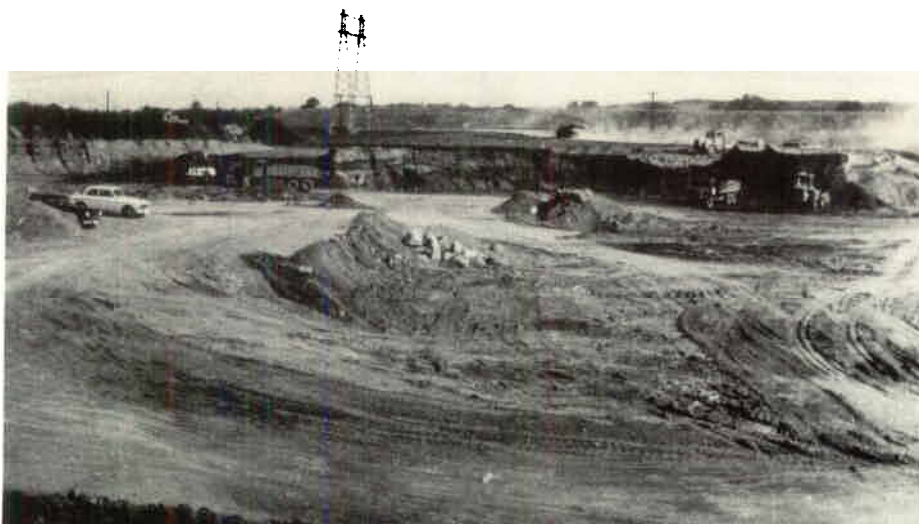
På en vårmånad i år togs i flygande fläng 60 000 m 3 sand och grus av dagbrottet Alberts avbaning till utbyggnaden av Gullfiber i det närbelägna Billesholm.
