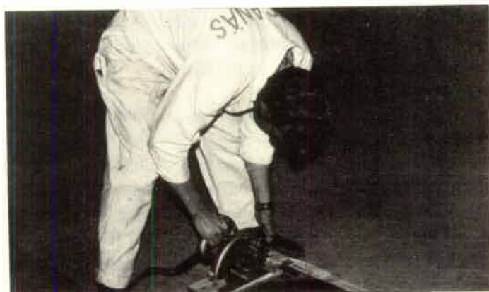
Medelst en elektrisk kapsåg på vilken monterats en karborundumskiva sågas det fyrkantiga hålet.
