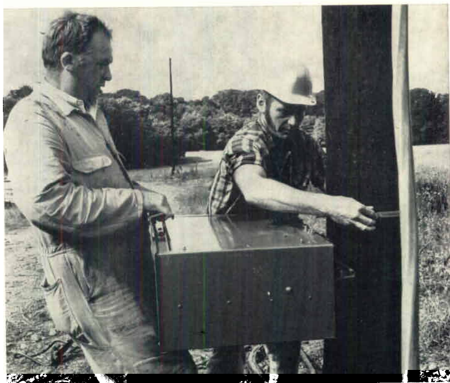
Kopplingsskåpet är en tung historia att få på plats, men med gemensamma ansträngningar sitter det snart där det skall.
