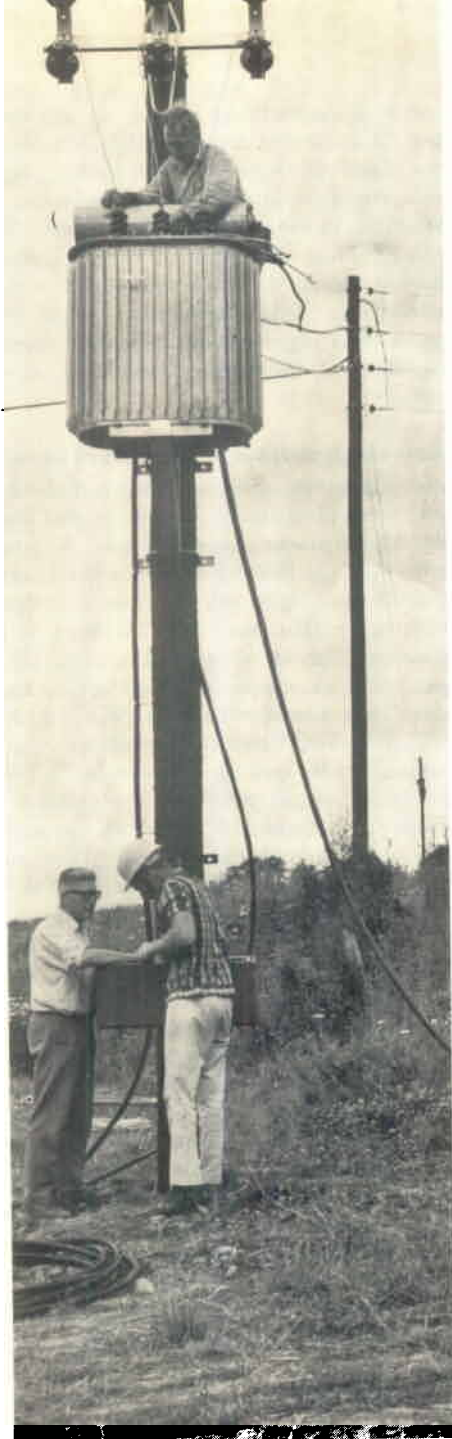
Askman och Sånge förbereder platsen för kopplingsskåpet. Holmgren arbetar med transformatorn.
