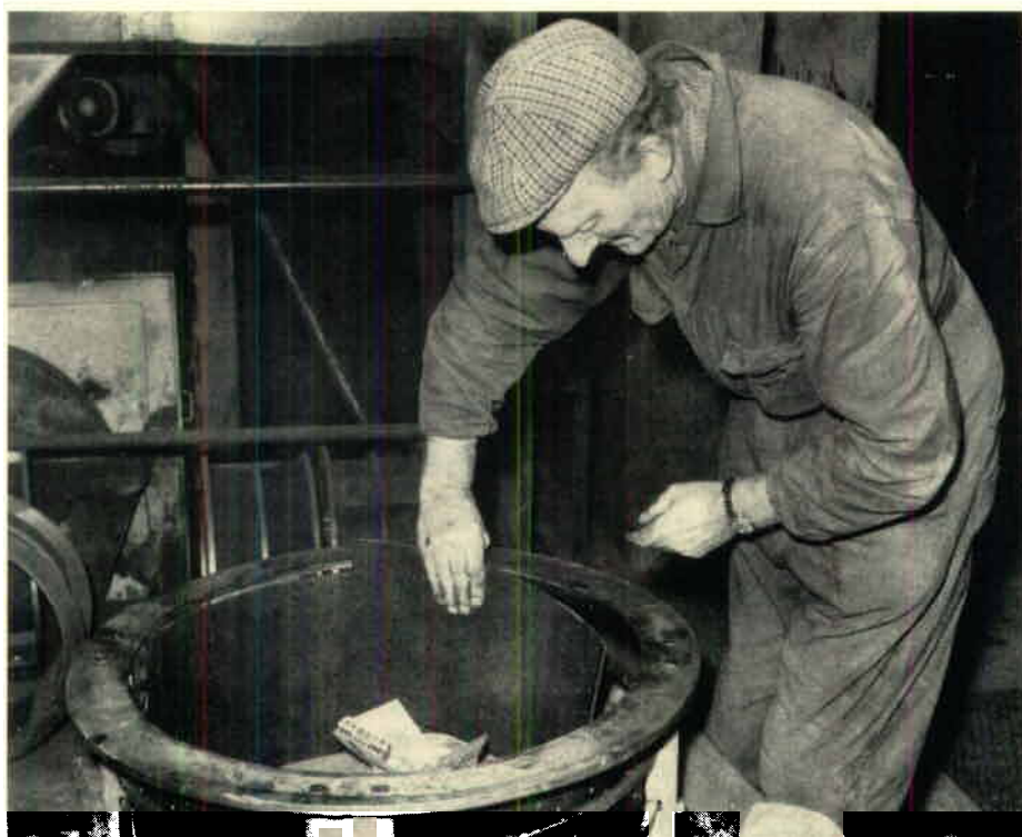
Uno Ivarsson byter siktplåtar så snart hålen blivit för stora i de gamla.
