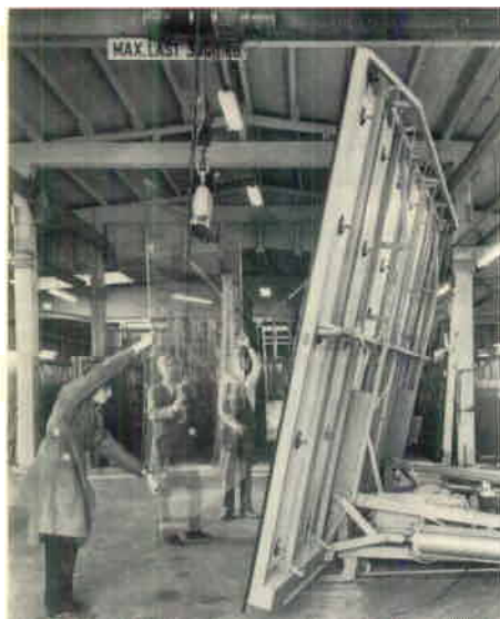
Glaset föres från lagret till avskärningsbordet som sedan sänks i lagom arbetshöjd. Bordet kan ta emot närmare 18 m 2 stora glas-skivor.
