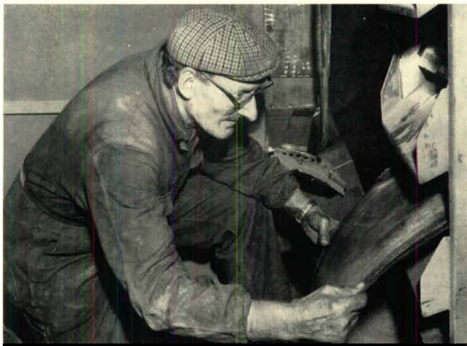
En Mogensensizer har många siktdukar i olika dimensioner från grovt till mycket fint. Det är ett lirande för att få dem av och på.
