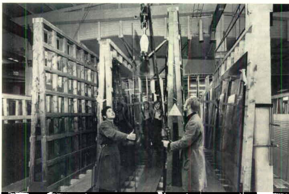
Framtagning av skyltruta för tillskärning å skärbord. Det är Cesare Moreno och Ulf Lindberg som hjälps åt med Bengt Carlsson längst in i bilden.
