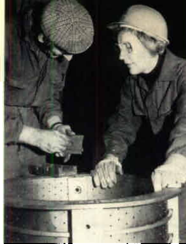
Uno visar Eva hur muttrarna borde sänkas in för att de inte ska bli slitna i förtid.
