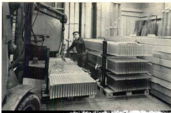
Herr Valter Andersson övervakar utlastningen av PROFILIT-glas från vårt lager i Limhamn f.v.b. till våra montörer, som håller på att glasa Svenska Mässans nya C-hall i Göteborg. Bild på denna hall hoppas vi kunna visa i nästa nummer av tidningen.
