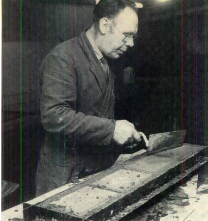
Verkmästare Ernst Andersson provgjuter det första glashlockselementet till Hultsfreds-Industrierna.
