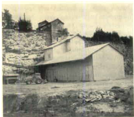
Krossningsanläggning för olivin. Grovtugg — fintugg — konkross — siktkollergångar samt siktar. Anläggningen ger ca 10 ton olivin < 4 mm per timma.
