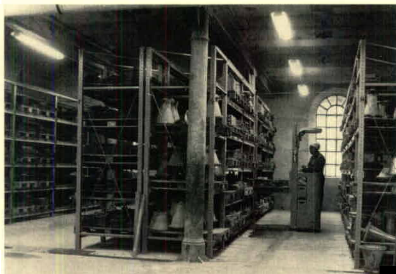
Formkontrollant Erik Ljung plockar fram pressformar ur lagret med hjälp av en staplare. Lagret innehåller ca 5 000 stålformar för pressning av eldfast tegel.
