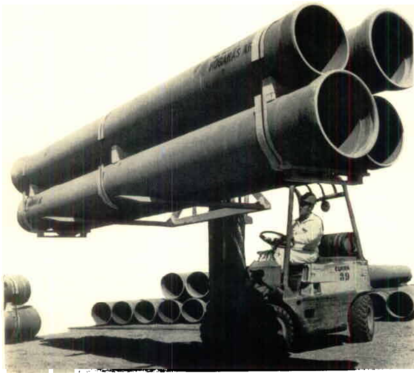
Sten Arvidsson har vi ofta sett på en annons med lätthet bärande ett FSP-rör över axeln. Fyra rör klarar han ej så lätt utan tar trucken till hjälp.
