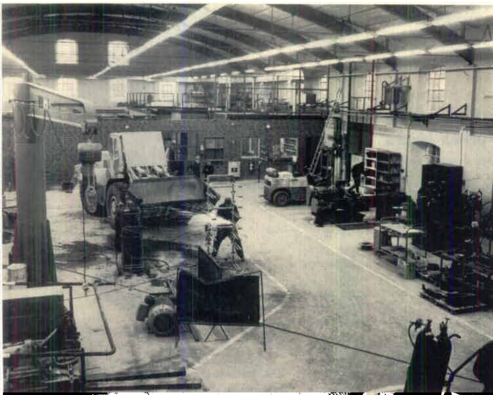
Verkstaden sedd "lidgegrann från ovan". En Parca 1254 skoplastare till vänster i bilden är inne för ombyte av skoppskär. Till höger står bearbetningsmaskinerna, svarv, kipp och slipmaskin.
