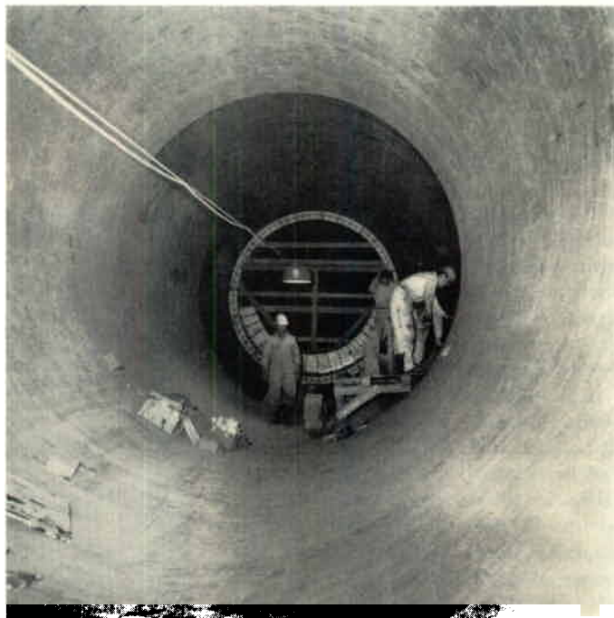
Här framgår med all tydlighet fördelarna med den s.k. "klistringsmetoden". Inga stämp som är i vägen. Ett bestämt antal sten i varje ring klistras fast mot plåtmanteln och motsvarar de av stämpan hållna stenarna.
