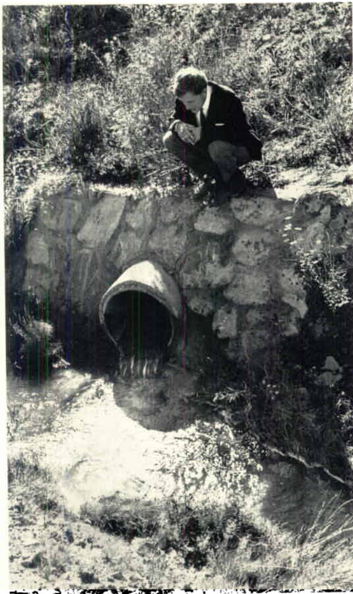
Ingenjör Sune Nilsson i Skromberga betraktar gruvans bräddavlopp till Bökebergsbäcken. Det är en glädjande och avgörande skillnad på vattnets kvalitet nedströms jämfört med rännen ovanför.
