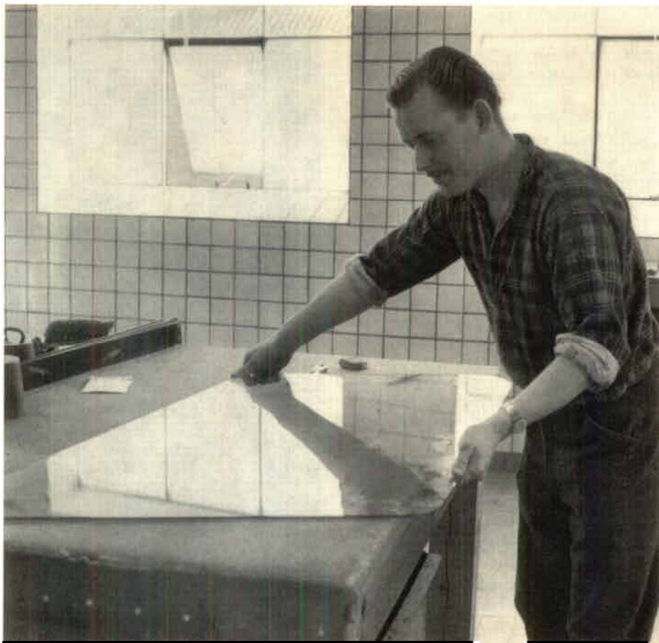
AB Trepex tillverkar också större säkerhetsglas för exempelvis lastvagnar, bussar och vägmaskiner. Här är det ofta fråga om mindre serier och följaktligen mera manuellt arbete. Einar Alm lägger här sista handen vid en ruta för en Åkerman-grävmaskin.
