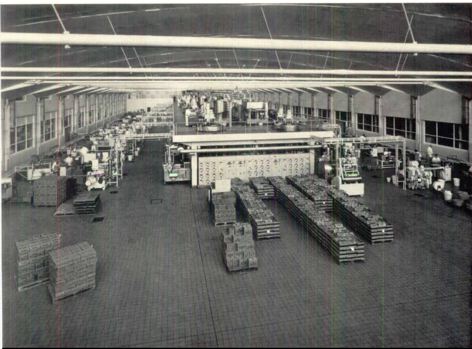
Till den engelska margarinfabriken Stork Margarine Works i Bromborough Cheshire har stora kvantiteter Högansbolagets plattor nr 200 och 500 gul från Skrombergaverken levererats bl.a. till denna tillverkningshall.
