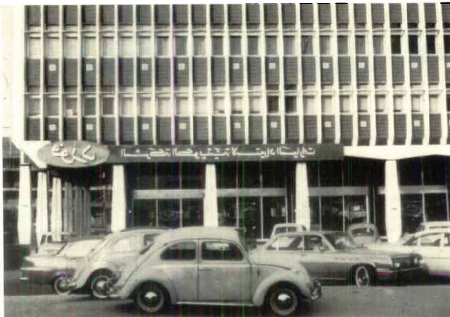
Byggnadsfasad i Kuwait klädd med Höganäs-plattor
