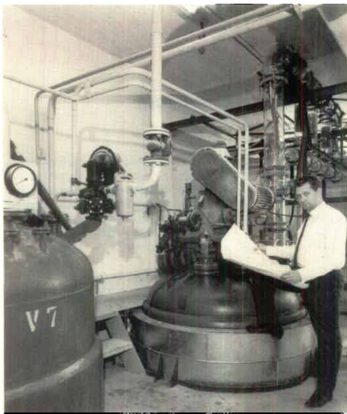
Ingenjör Bernt Stalbrand, biträdande driftsledare i Teckomatorp, kontrollerar ett installationsarbete vid förestringsanläggningen.
