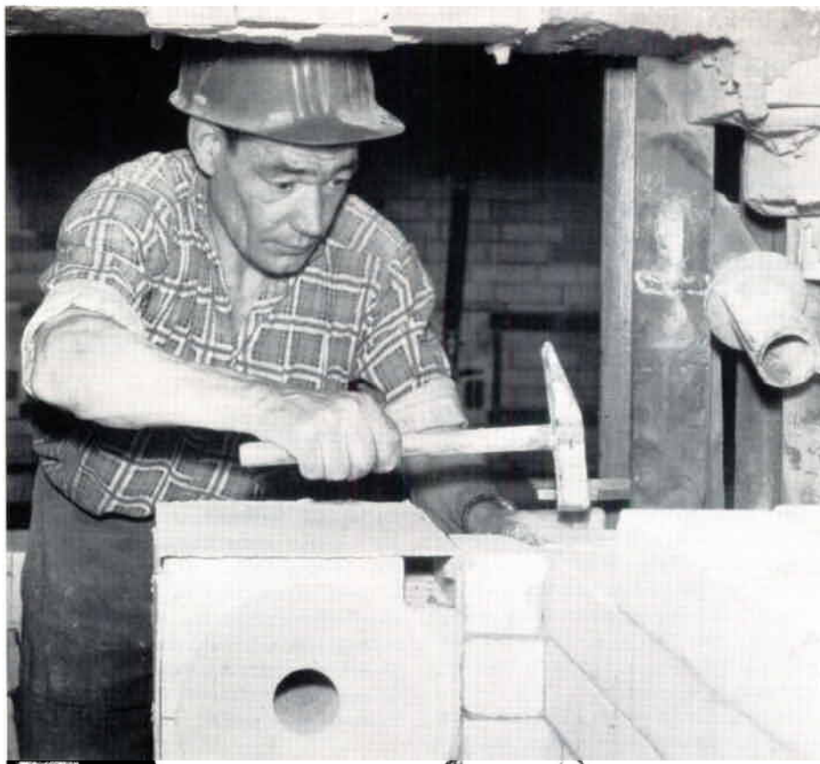
Bjuvsverken har under arbetarsemestern byggt om brännzonerna i tunnelugn I och II till oljeeldning. Det uppgjorda tidsschemat hölls exakt. AB Höganäsarbeten har svarat för ombyggnaden och anlitat bl.a. ett tjugotal tyska ugnsmurare. På bilden en av dem — Heinz Dämmig från Mühlheim/Ruhr.
