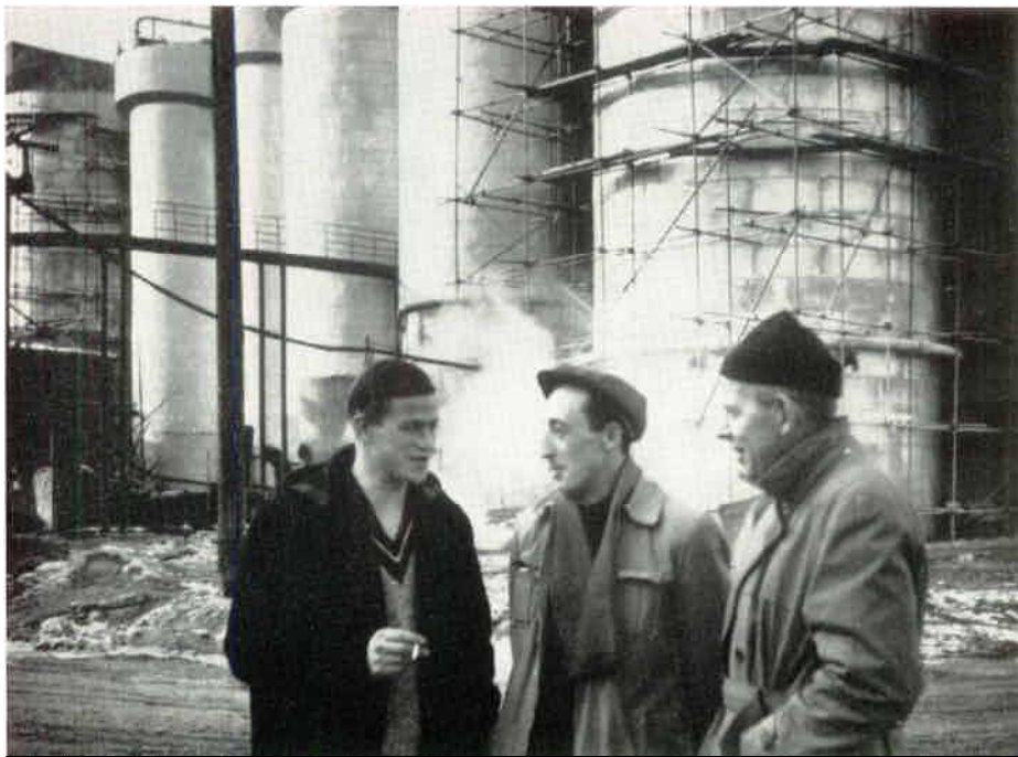
Höganäsmurarna Sonny Bergkvist och Elon Wennbom flankerar en rumänsk arbetsledare vid Combenatul de Celulosa i Calarasi. I bakgrunden syns t.h. det kloridoxidtorn, som de båda murarna på uppdrag av AB Höganäsarbeten inmurat med 40 mm blektornstegel och s.k. Stebbinstegel.
