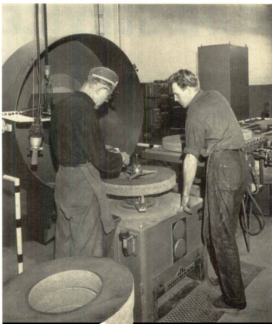
Instruktör Erik Ströberg, Västervik, f.v., instruerar eleven Karl Axel Ljungholm i dynamisk balansering och olika principer för måttagning.
