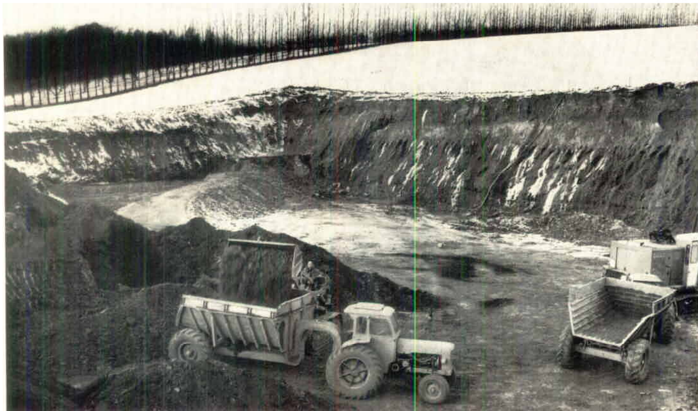
I Skromberga södra dagbrott, som öppnades i september 1963, bryter man brunbrännande klinkerlera. Dagbrottet täcker 3—4 års behov.
