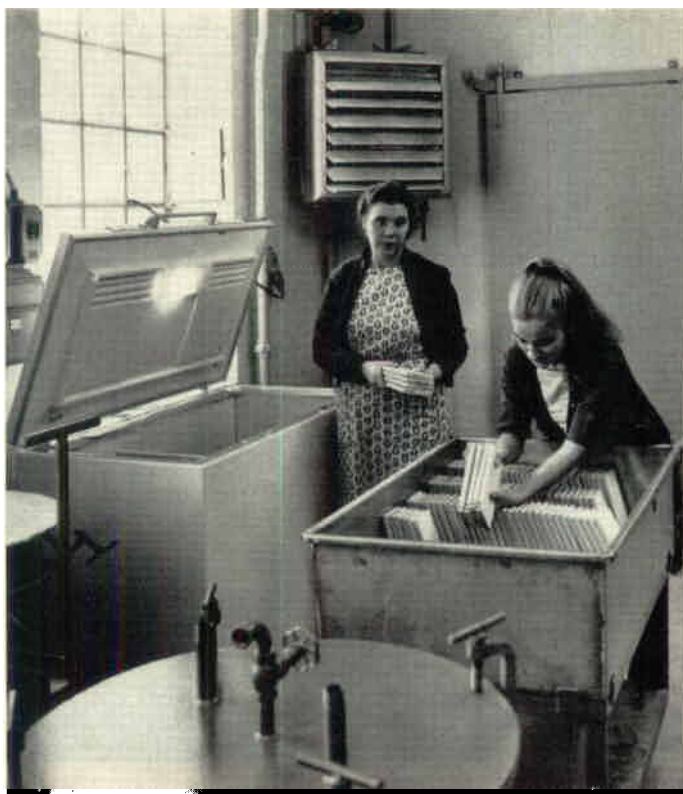
Fru Gulli Olsson, som tycker det går fint att vara förvärvsarbetande fru, och fröken Brita Flink, som på lediga stunder gärna läser litteratur med Vilhelm Moberg som älsklingsförfattare, hjälps åt med frostbeständighetsprov, kontroll av vattenabsorption och siktanalyser.
