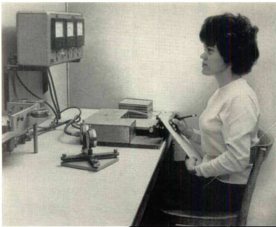
Fröken Brita Wendel, som har sång och musik som hobby, gör måttkontroll, dvs. fastställer event. vinkelavvikelse och kupighet på plattorna. Pappa Gunnar är anställd som klinkersorterare.
