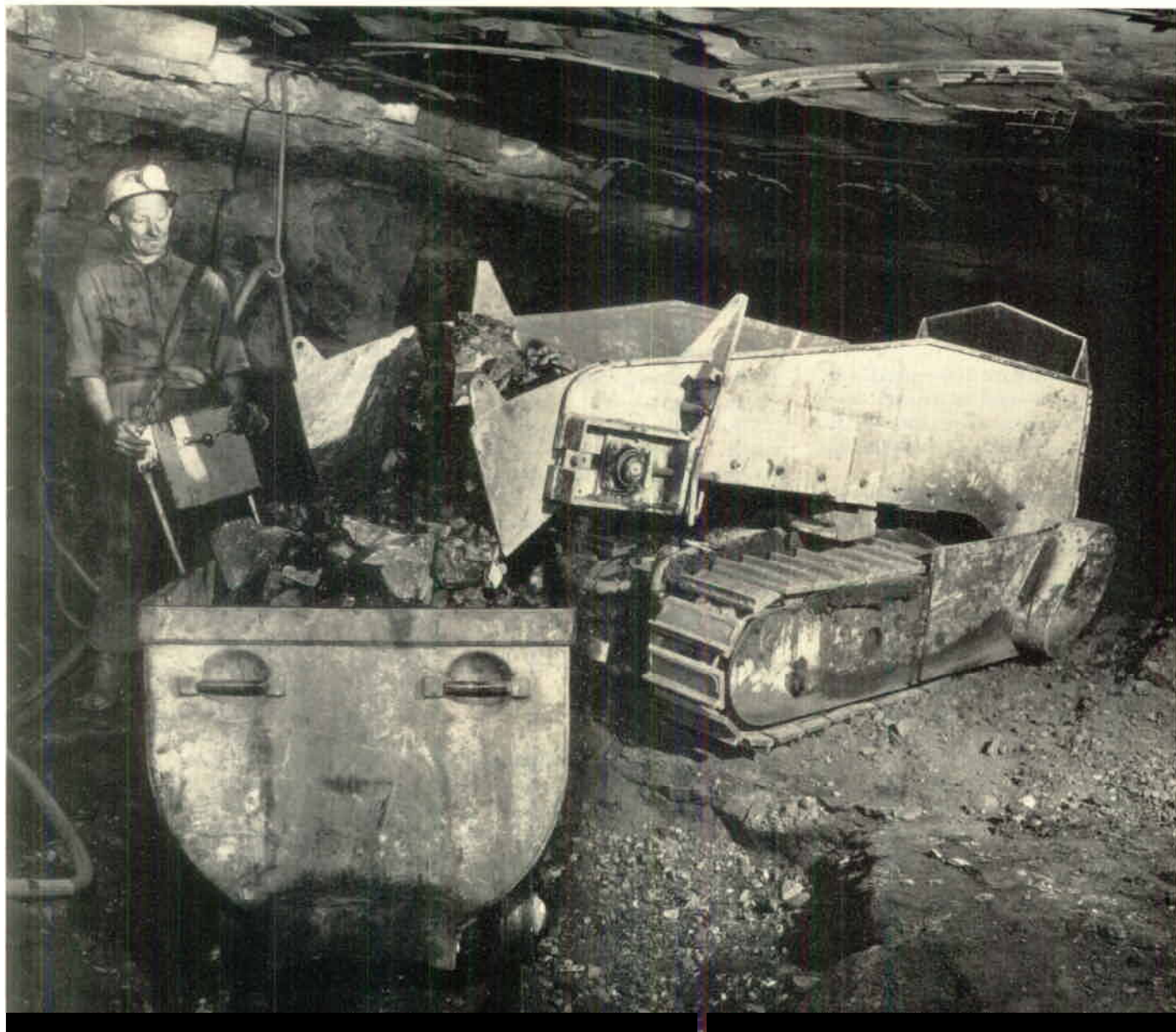
I Schakt III i Bjuv provas denna av gruvarbetare Nils Fredriksson fjärrstyrda lastmaskin under jord
