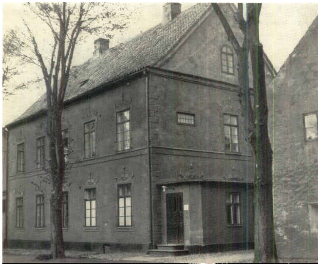
I denna byggnad hade dr. Gustaf Alling bostad och läkarmottagning. Den låga tillbyggnaden utgjorde väntrum. T.h. en del av den fastighet, där Höganäs Museum i dag residerar. Innanför det nedersta fönstret hade dr. Anders Nyman på sin tid läkarmottagning.
