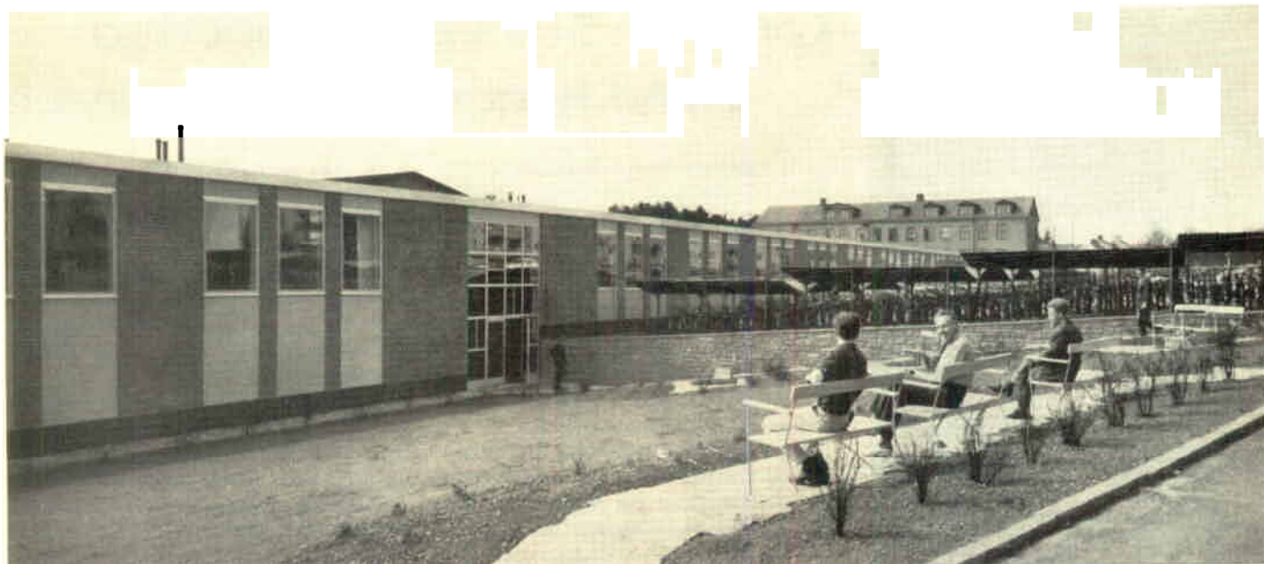
"Sliparna" Lennart Enström, Erik Edling och Charles Johansson lapar vårsol i planteringen framför Slip-Naxos' nya fabriksentré. Fasaden på den nya lagerbyggnaden, som vetter mot den blivande huvudinfarten till Västervik, är 110 m lång. Blå Höganäs-plattor ger färg och liv åt den långa tegelväggen.
