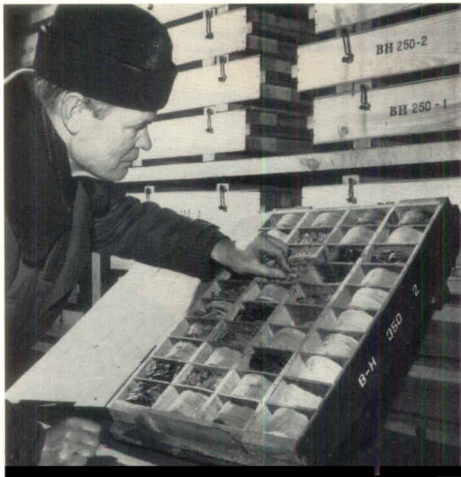
Problemet att kombinera stötblorning med provtagning av solida borrar-kärnor löstes 1951 av dåvarande borrar-förmannen Edvin Thalín genom en enkel och smält genial konstruktion, efter uppfinnaren kallad "Thalíns trattmetod".
