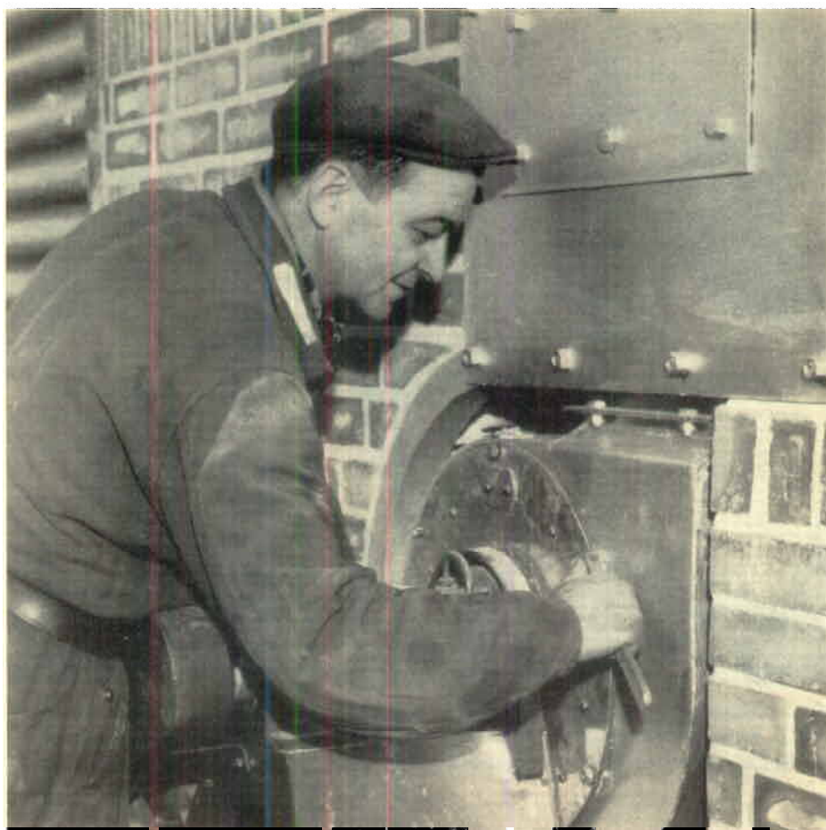
Reparatör Einar Norlin, Bjuvsverken, är en mycket intresserad kontaktman för Bolagets korpiddrott. Här syns han under montagearbete på den ena av de två nya tunnelugnarna.
