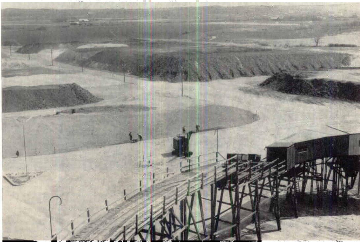
Ovan: Det rymliga lagerområdet vid Schakt III. 16—17 chamottehögar, vardera om 26—27 tusen ton, får där plats. Det tar ungefär tre månader att lägga ut en sådan hög, som sedan får självbrinna i åtta månader. Nedan: En speciell s.k. sandlera säljes till Reymersholms Gamla Industri AB i Hälsingborg. Här väges ett lass sådan lera.
