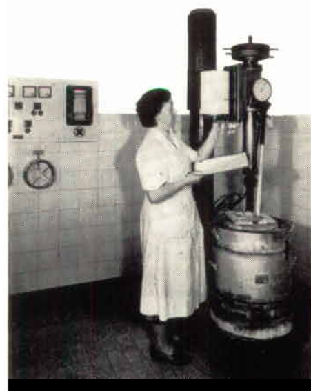
Fröken Edith Burmeister är chef för laboratoriet. Här bestämmer hon mjukningstemperaturen för ett eldfast material.
