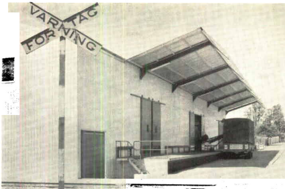
Exteriör av nya lagerbyggnaden vid Glasullsbolaget i Billesholm
