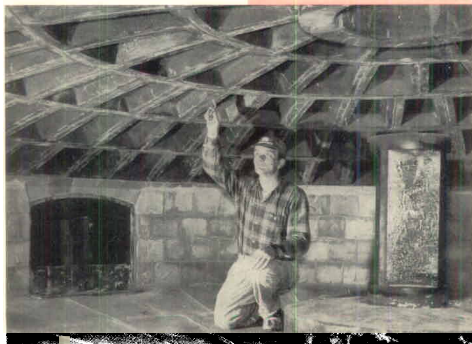
Murare Gustaf Johannesson utför finish på undersidan av ett SICTO-valv i en sulfatugn vid Kopparverket i Hälsingborg.
