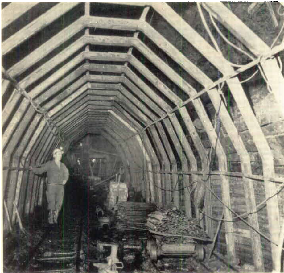
Detta är inget nyligen påträffat skelett av en skräcködra utan en förbyggnad i Bjuvs gruva, Schakt III. I gruvan har vagnsommeloppel omorganiserats bl.a. genom att gamla orter utvidgats. Innan arbetet påbörjades, byggde man i modell upp förbyggnaden. Den stora bilden visar, hur denna tog sig ut i praktiken. T.v. gruvfogde H. Eriksson, som har lett arbetet.
