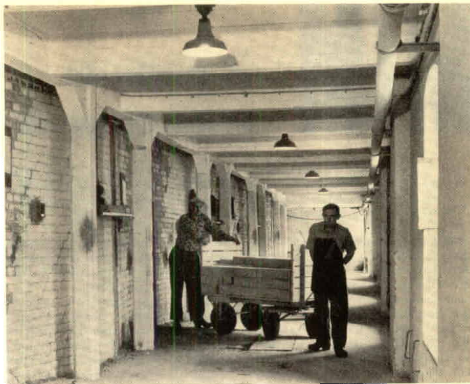
De gamla decauville-spåren vid klinkerkammarrugnarna i Skromberga har försvunnit. Nu användes i stället luftgummihjulsvagnar för transporten vid sättning och tömning av kamrarna. Här håller Ebbe Wiberg och John Larsson på med tömning av en kammare med det nya transportsystemet.
