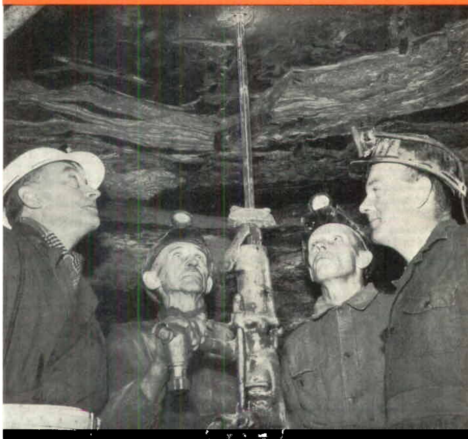
Bergsmän från Zinkgruvan har studerat bergförankring i skånegruvorna. Här demonstrerar gruvarbetsare Edvin Johansson, Gunnarstorp, andra man fr.v., metoden "roof bolting". Åskådare är ing. Z Pilch, Höganäsbolaget, samt ingenjörerna A Persson och C A Widén från Zinkgruvan.
