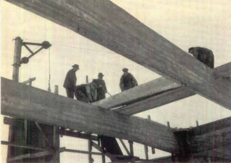
Västervik: Den nya ugnshallens första takplatta lägges på. När denna tidning går i press, torde sista plattan vara på sin plats.
