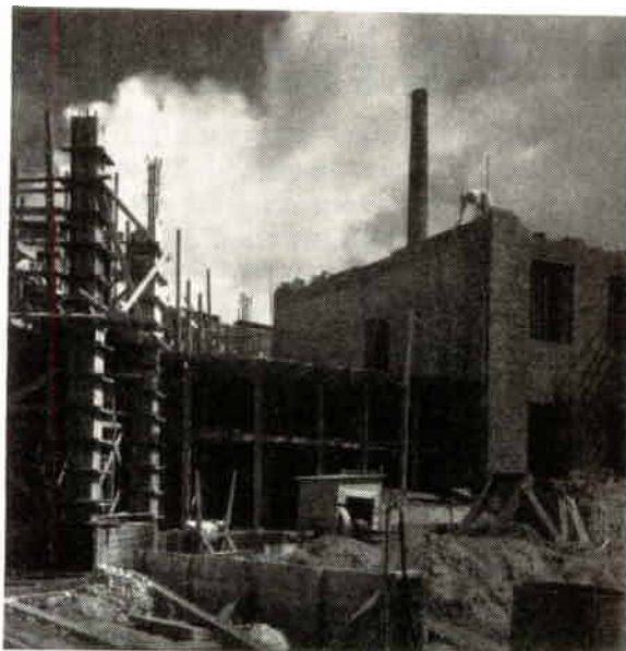
Det nya laboratoriet i Höganäs skjuter i höjden. — När detta skrives (sept.), har byggnaden kommit upp i full höjd och inredningsarbetet påbörjats.
