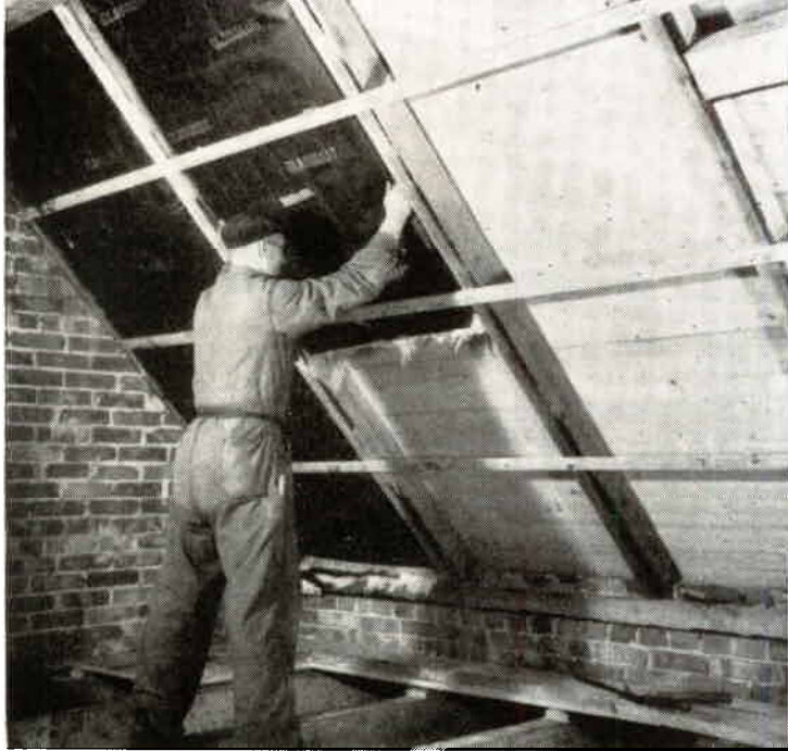
Ett yttertak isoleras med Glasullit, typ S.
