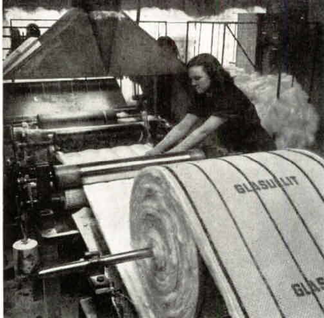
Fru Anna Skoog, f.n. medlem av Glasullsbolagets samarbetskommitté, passar här en symaskin för tekniska Glasullit-mattor. Dessa är som synes försedda med pappersunderlag, på vilket ordet Glasullit är tryckt. Sådan märkning anbringas på Glasullit-produkterna i all den utsträckning detta är möjligt, och de järnvägsvagnar, som avgår, är försedda med Glasullit-skyltar.
