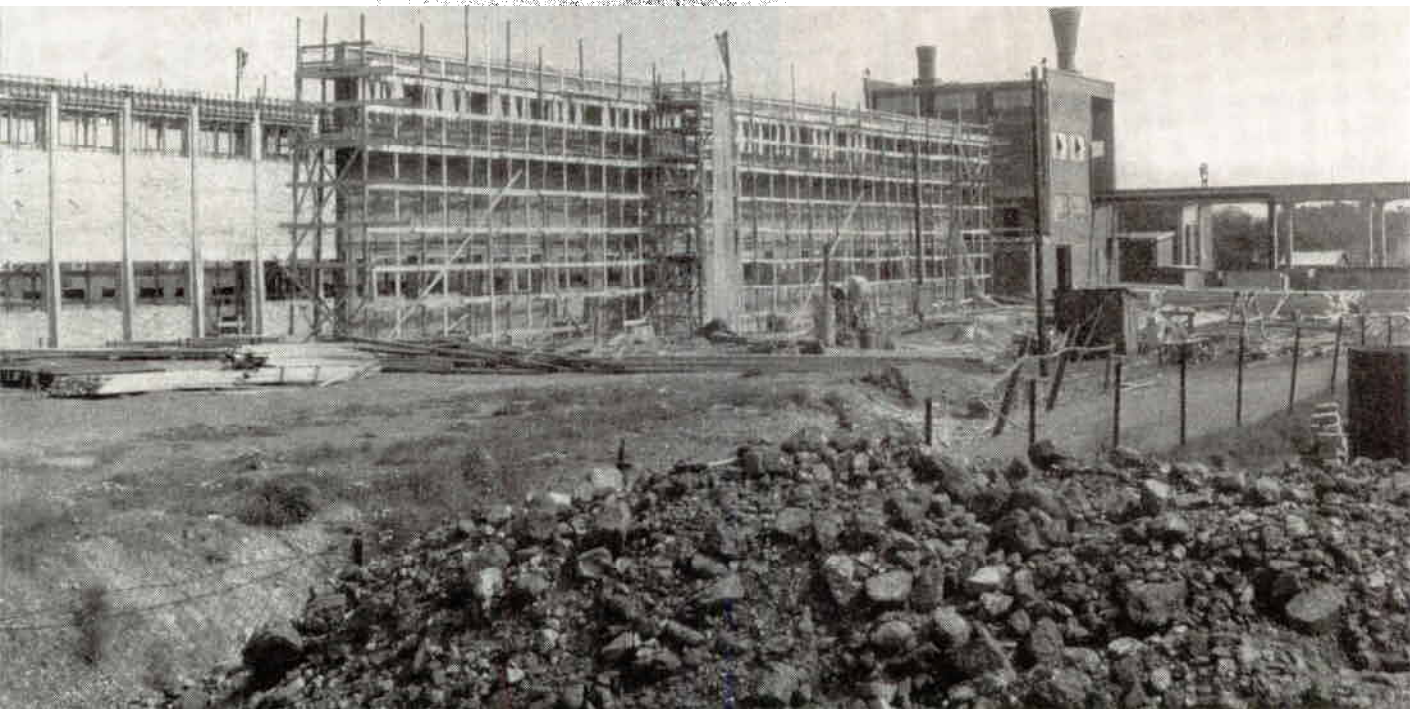
Den imponerande tillbyggnaden av nya Smältverket för Alumo i Höganäs, som skall inrymma kross- och siktverksavdelningarna. I förgrunden lager av bauxit, råmaterialet för Alumotillverkningen.
