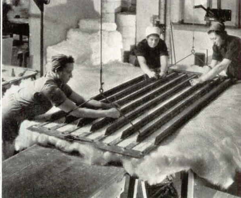
Fruarna Elin Håkansson, Elsa Johansson och Gunhild Svensson syr »mattor efter mått». Med flinka fingrar föres nålen ned genom mattan, och innan man hinner blinka, är den uppe igen. När ett stycke av mattan är färdigsytt, renskäres överskjutande kanter, ny glasull matas på bordet, och så fortsätter det, tills mattan har fått den önskade längden.
