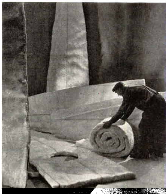
Herr Emil Svensson sysselsatt med att packa in »mattor efter mått». Dessa mattor har ibland namn, som påminner om herrskrädderi, t.ex. pannvästar, avsedda för isolering av värmeledningspannor.
