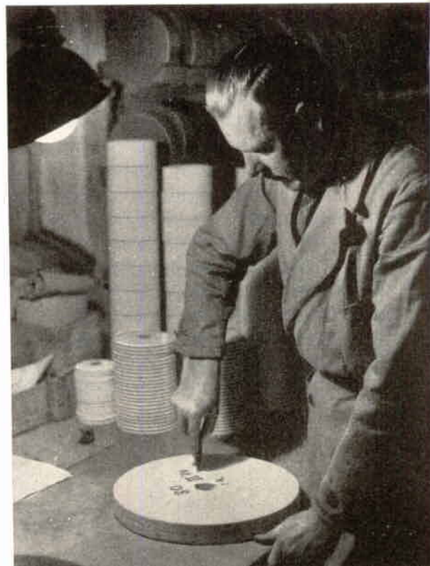
T. h. . . . i Lomma av Gunnar Söderquist, som för hårdhetsprovningen begagnar sig av handmetoden.
