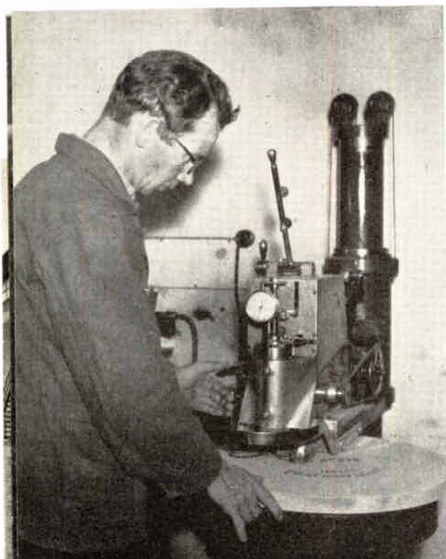
T. v. Slipskivorna genomgå den slutliga skärselden, i Västervik »fyrad» av Martin Andersson, som provar hårdheten i en s. k. gradometer . . .
